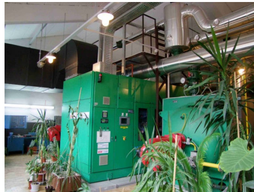
Slika 4: Kotlovnica Dobrava in kogenerator
